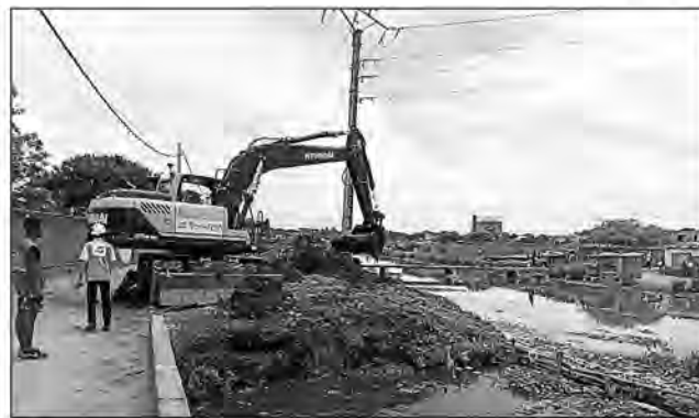
Travaux de curage menés par l'APIPA avec la tractopelle à roues fournie par le PRODUIR.
