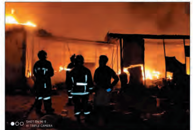
Le bloc Amical II ravagé par les feux en 2020.
