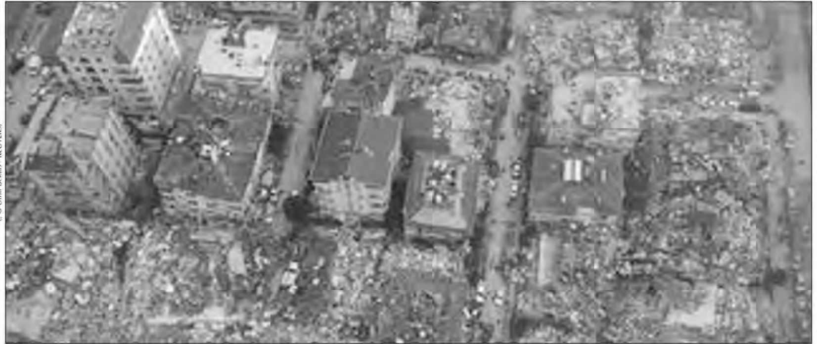
Une vue aérienne de bâtiments effondrés ou en partie détruits suite à Hatay, en Turquie.
