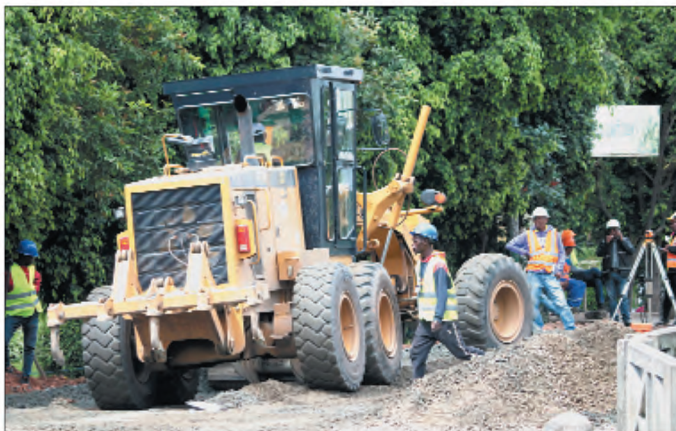
Travaux de réhabilitation de routes, à côté du By-pass et à Ankadimbahoaka.
