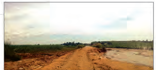
Les travaux d'urgence ont permis de rétablir la circulation
