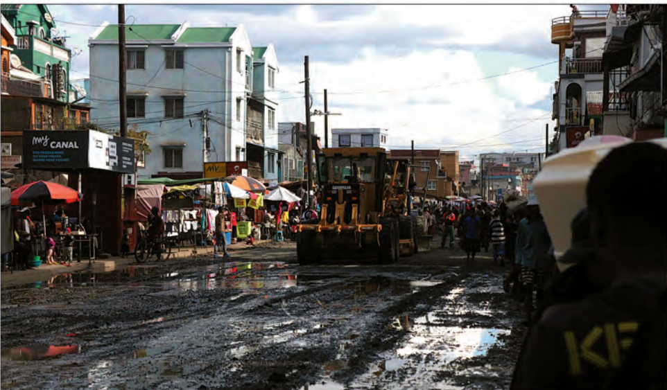
La rue à Ambodim'Isotry était complètement coupée à cause de travaux de réparation.
