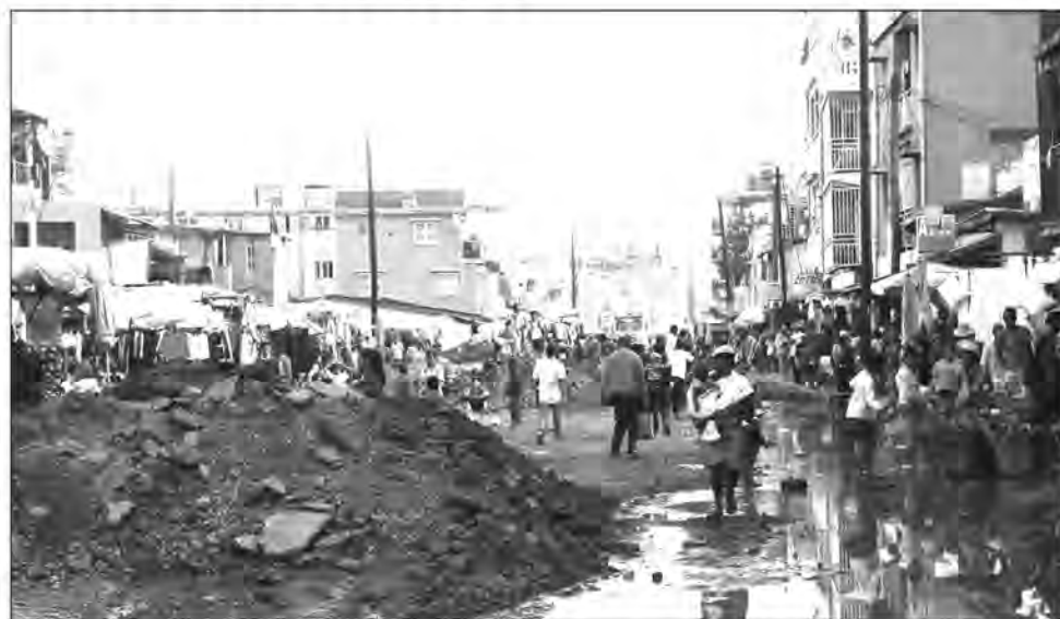
Branle-bas de combat pour la réhabilitation des routes à Antananarivo.
