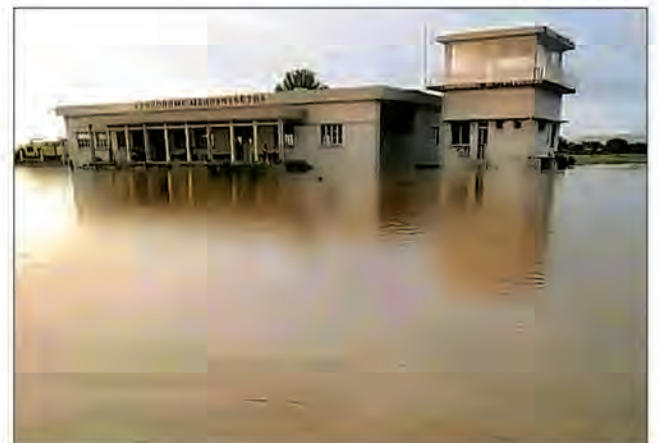
L'aéroport de Maroantsetra est complètement inondé.
