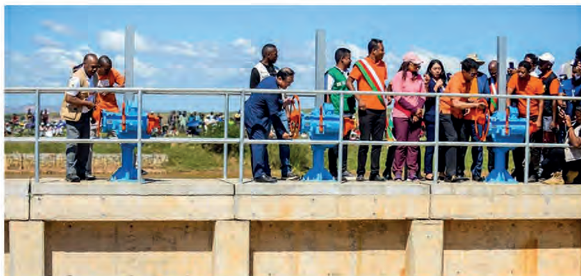
Inauguration du système d'irrigation PC23 en mai 2022 en la présence du Président de la République de Madagascar SEM Andry Nirina RAJOELINA, de l'ancien Ambassadeur du Japon à Madagascar SEM Yoshihiro HIGUCHI et du Ministre de l'Agriculture et de l'Elevage, Mr Harifidy RAMILISON
