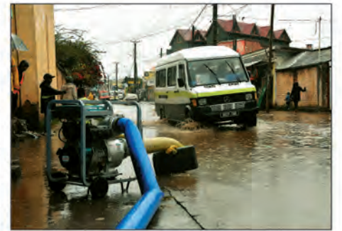
Déploiement d'une motopompe à Ilanivato pour accélérer le tarissement de l'eau.
