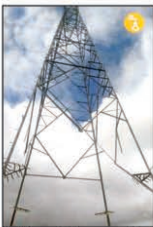
Toy izao ny fahavozazana hita tamin'ilay pylône eny Antanandrano.
