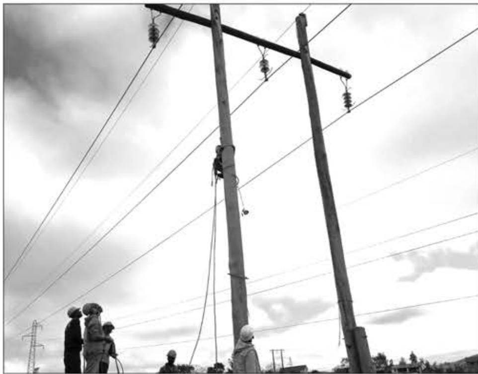
Avec les travaux menés par la Jirama, il ne se passe pas une journée sans électricité ne soit coupée
