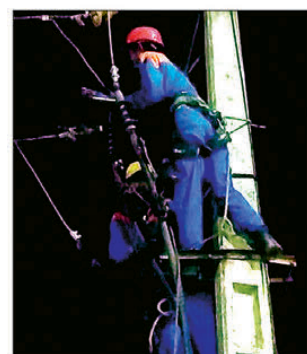
Les agents de la Jirama remplaçant une tête de câble, à l'origine de la coupure de courant au niveau de sa station Ambohimambola.
