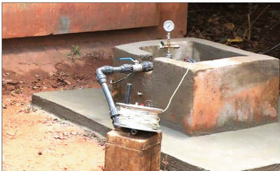
Le dispositif remis en état à Ankatso I, a été remis au CROUA, hier.
