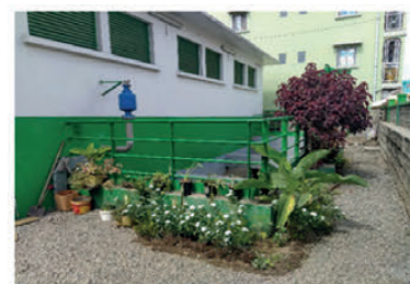
Rehabilitation de la station de pompage 67ha Travaux 1ère phase du PIAA
