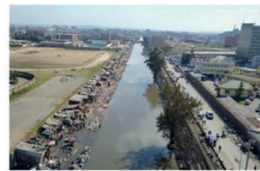
Curage du Canal Andriantany - Travaux 1ère phase du PIAA
