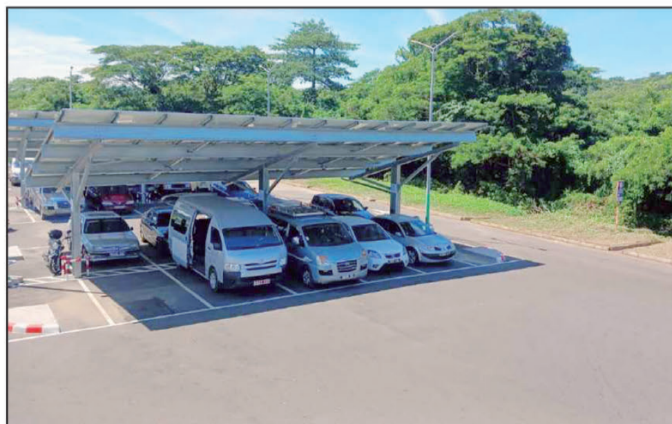
Azon'ny fiara ialofana toy izao ireo " Ombrières solaires " ao amin'ny seranam-piaramanidina Nosy Be.
