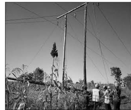
Travaux de remplacement de poteaux en cours sur la ligne reliant Ambohimambola et Antsirabe.
